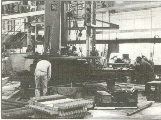
Vue de l'intérieur de Marine Industries en 1981.
