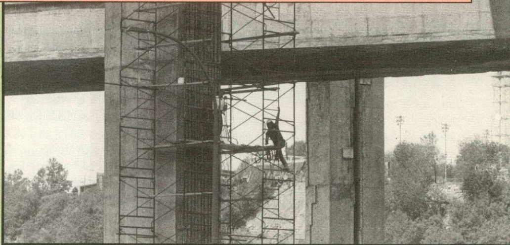
Le tristement célèbre échangeur Turcot, à Montréal, où sept ouvriers ont été tués, lors de sa construction, parce qu'on avait négligé de vérifier la résistance d'un coffrage et son échafaudage avant la coulée de béton.
