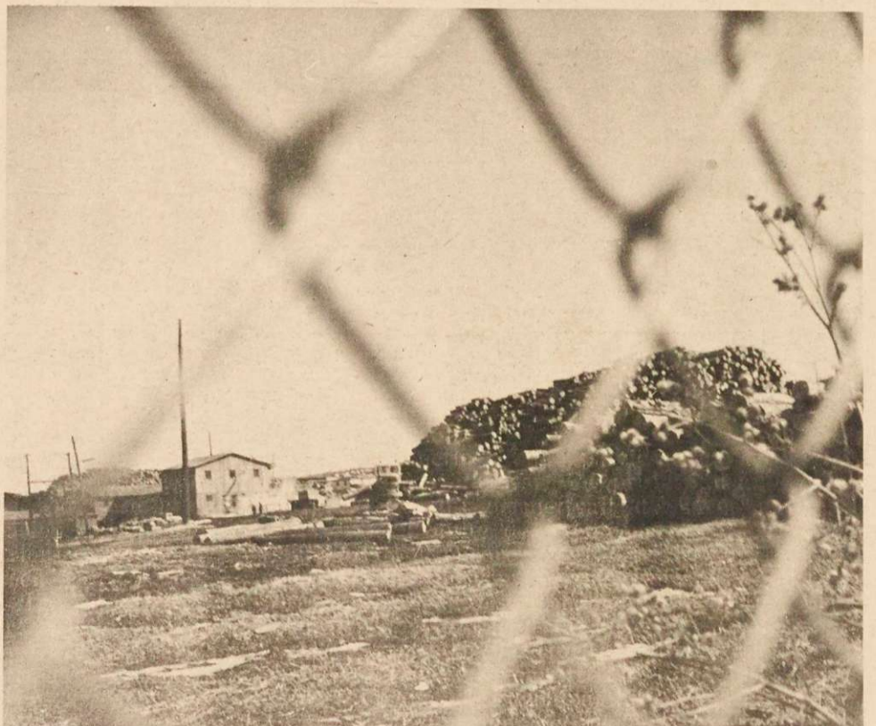
Derrière cette clôture, et sous la protection d'un ordre de la Cour interdisant tout piquetage, la Bellerive Veneer & Plywoods a repris ses opérations. L'usine tourne au ralenti grâce à des briseurs de grève que la compagnie a réussi à recruter parmi les fermiers des environs que les travaux de la ferme laissent libres pendant les mois d'hiver.
