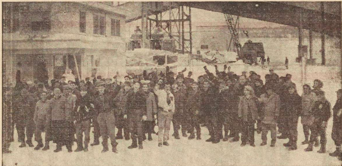
Le piquetage devant la barrière de la National Asbestos Ltd.
