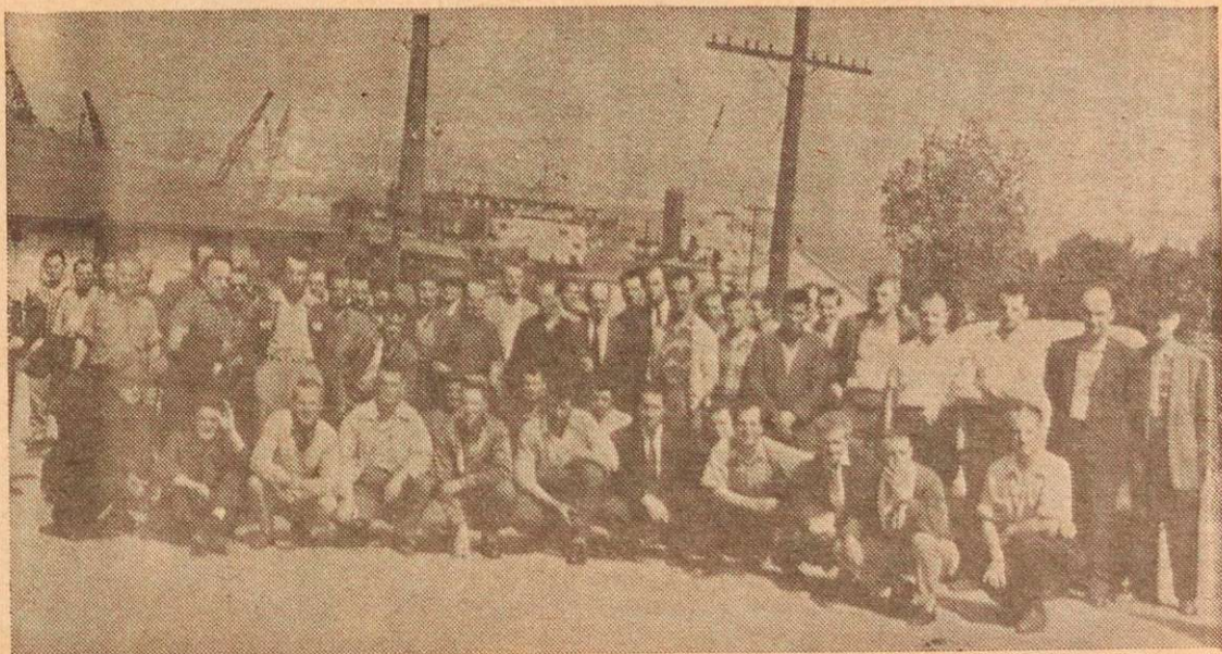
A l'entrée principale qui donne accès sur les chantiers de Davie Shipbuilding, un groupe de piqueteurs paisibles mais vigilants montent également la garde.
