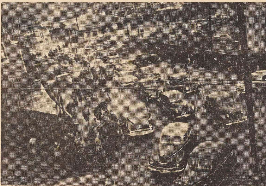
Le travail vient de finir et les ouvriers des chantiers maritimes quittent l'usine pour rentrer au foyer. Plus de 1,500 travailleurs gagnent leur vie sur ce chantier où s'effectuent la construction et la réparation des navires. Scène typique de la vie ouvrière et qui met en oeuvre tous les moyens de locomotion: l'auto, la bicyclette et... le train no 11, comme on dit à Chicoutimi.
